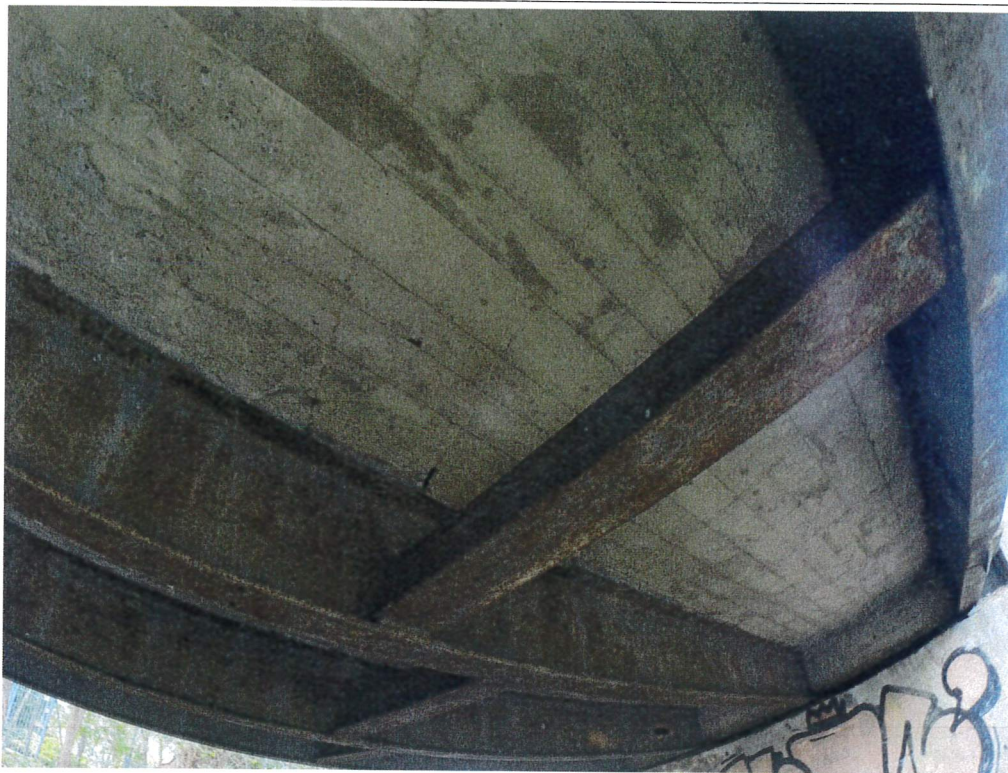
Fot. 3. Korozja dźwigarów głównych
