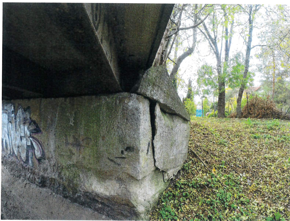
Fot. 4. Peknięcie betonu, przemieszczenie konstrukcji skrzydła
