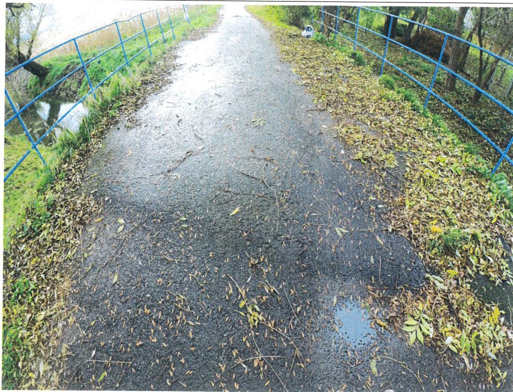
Fot. 1. Deformacja nawierzchni jezdni
